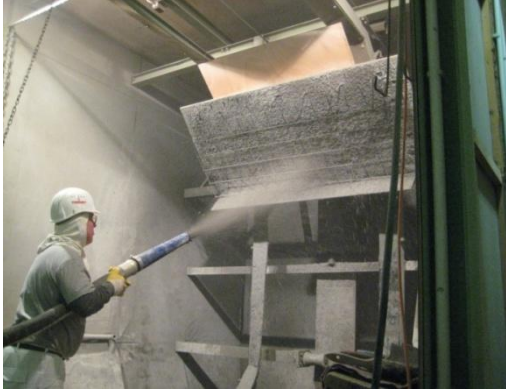
Applizieren des Spritzbetons überkopf
