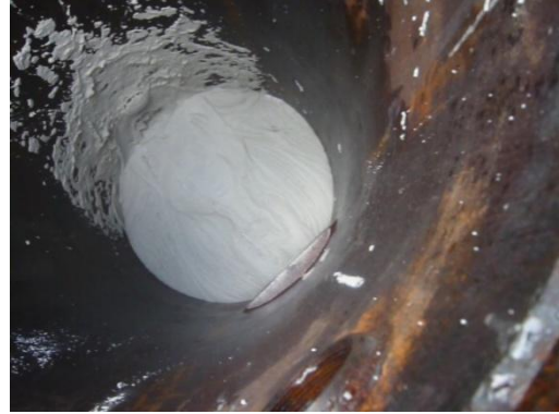
In einen Druckbehälter eingebrachter Ringspaltmörtel
